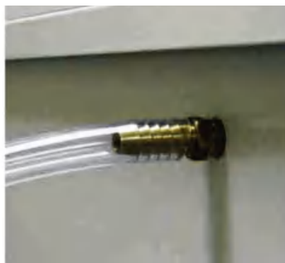
集尘效率测定用喷管安装
